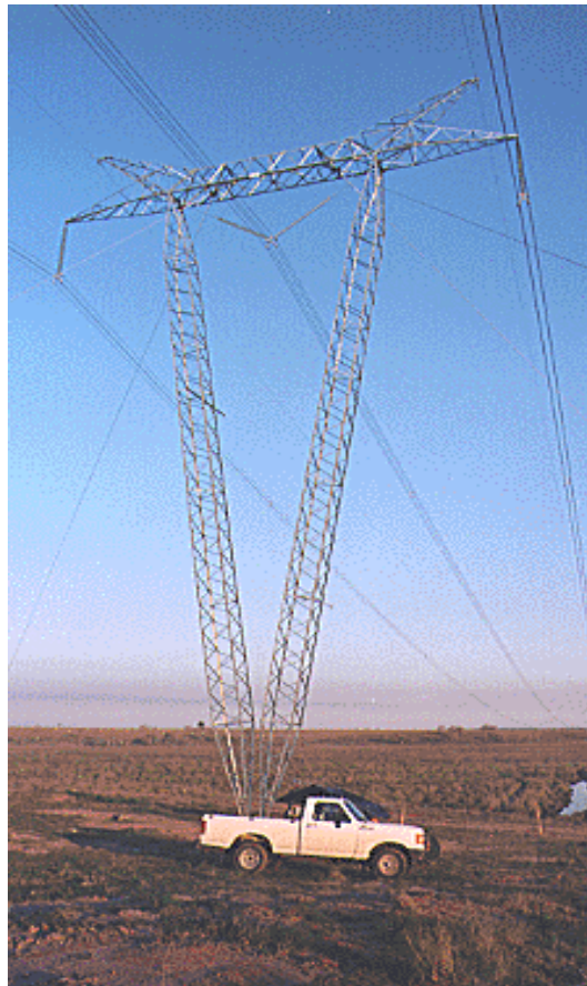
Figura: Líneas de transmisión sobre estructura metálica.
